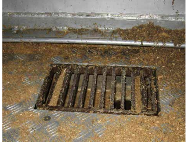
Trou de vidange: largeur trop grande des fentes.
