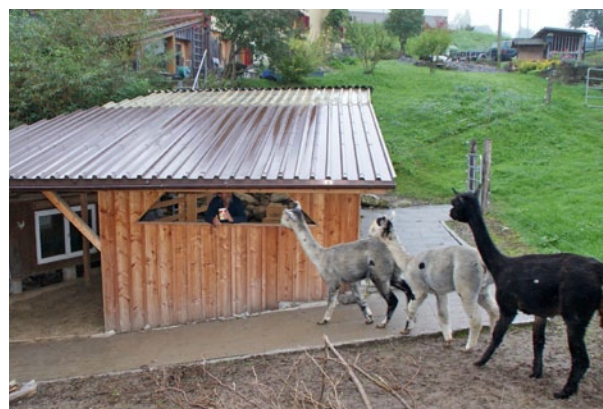
La place autour de l'étable est renforcée par des dalles.
