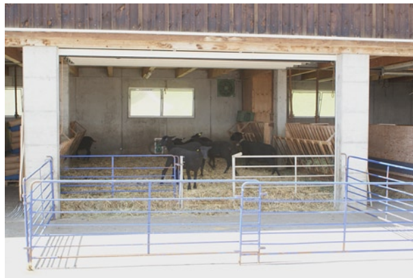
Vue du compartiment médian des trois compartiments que compte l'étable. La place frontale asphaltée est facile à nettoyer et sert d'aire d'exercice.
